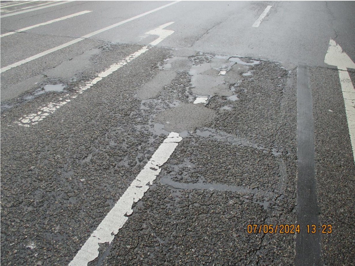
Fotos Asphaltbelag Basler Straße: Abschnitt Hammerstraße – Dammstraße
