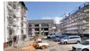
Baustelle, rechts und links der Altbestand
