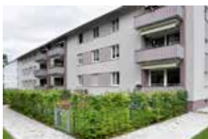
Karlsbader Straße 18 bis 20
