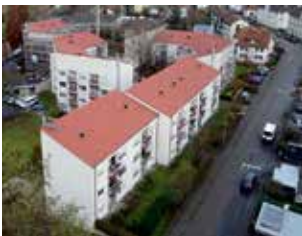
Wölblinstraße nach der Sanierung
