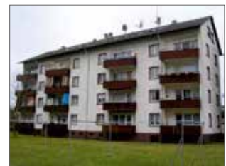
Ortmattstraße vor der Sanierung
