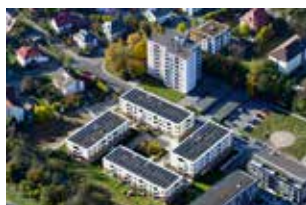
Dachaufsicht mit Photovoltaik Foto: Erich Meyer
