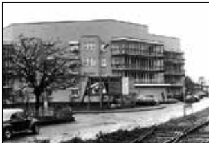
Wölblinanlage beim Bau 1980
