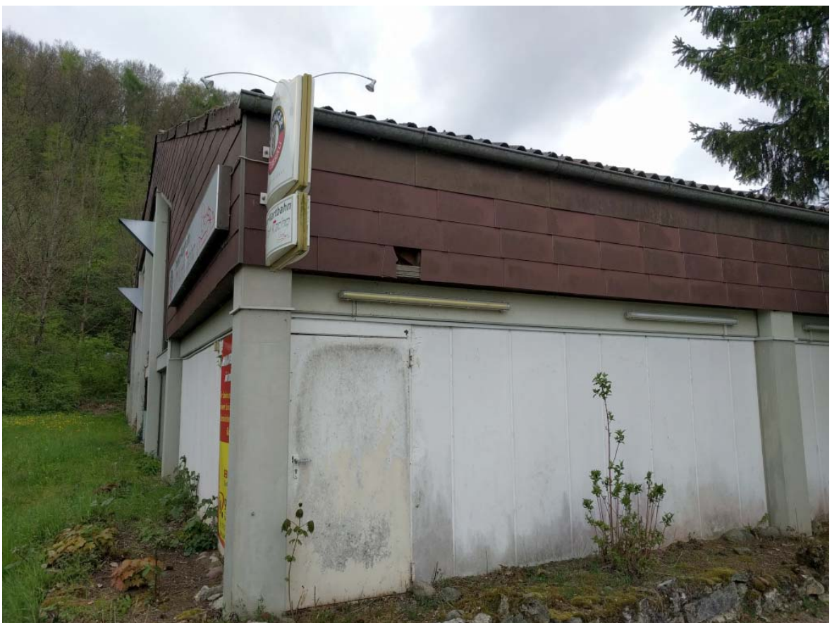
Abbildungen 11 und 12 Sanitärgebäude und Kartbahnhalle
