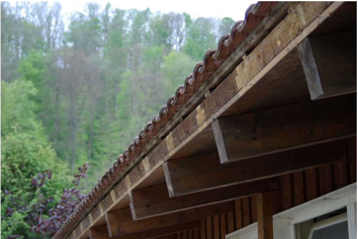
Abbildungen 13 und 14 Potenzielle Spaltenquartiere im Sanitärgebäude
