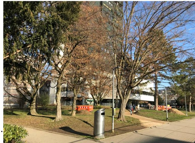
Auch die mittlerweile hohen Bäume sind problematisch, da sie alle zwischen den Stützenfeldern stehen und die Last nicht auf die Konstruktion abgetragen werden kann.
