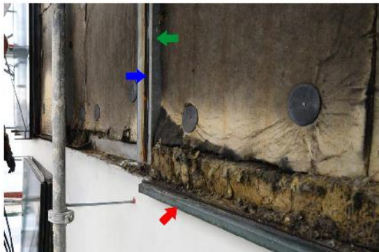
Foto 06: Bauteilöffnung am 21.11.2017, Stahl-U-Profil (grün), Kunststoff-Dichtprofil (Blau), Abschlusswinkel (rot)
