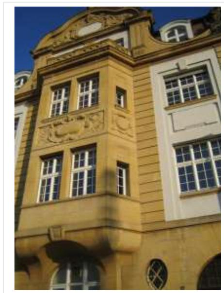
Abb. 19: **B-GMFH**: Großes Mehrfamilienhaus (476 m<sup>2</sup>) aus der Gründerzeit, mit kunstvoll gestalteter Sichtfassade, mögliche Außenwanddämmung von 50 %.
