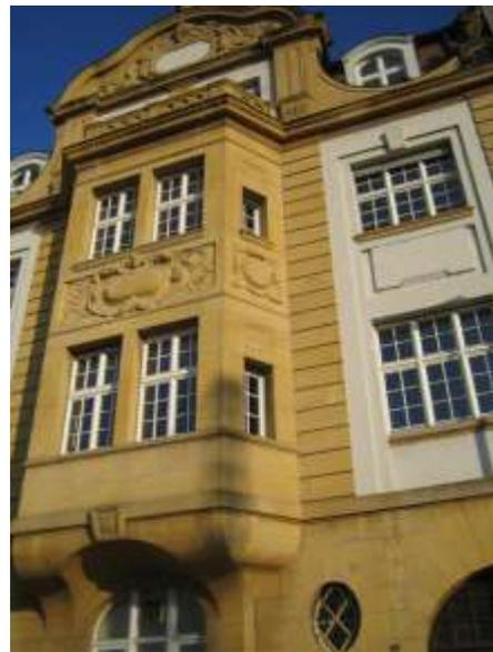
Abb. 37: **B-GMFH**: Großes Mehrfamilienhaus (476m<sup>2</sup>) aus der Gründerzeit, mit kunstvoll gestalteter Sichtfassade, mögliche Außenwanddämmung von 50%
