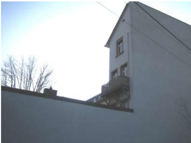
Abb. 18: Grenzbebauung führt ggf. zu baurechtlichen Einschränkungen hinsichtlich der für den Wärmeschutz erforderlichen Dämmung – Beispiel aus der Belchenstraße.
